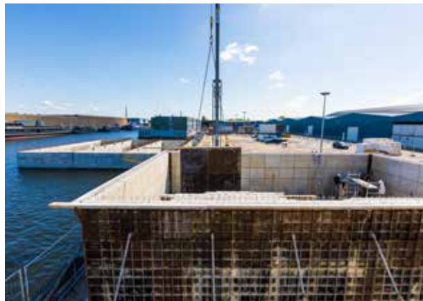
In dit project zijn de betonnen drijflichamen op het land naast het water gestort. Vanwege hun afmeting en gewicht pasten ze namelijk niet in de droogdokken van de traditionele arkenbouwers.
