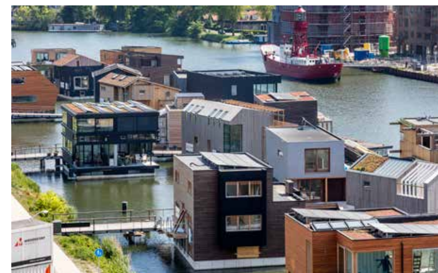
Via een smart grid wordt de verkregen energie naar behoefte onder de woningen verdeeld, waarbij het verbruik per woning wordt bijgehouden.
