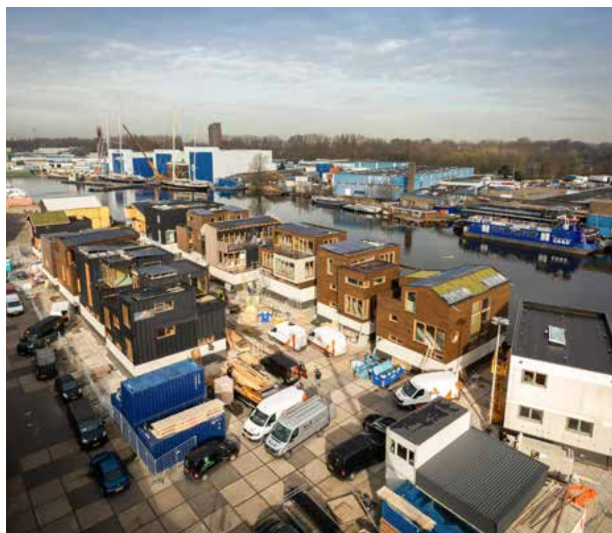
“Op 11 mei zijn alle waterwoningen naar hun eindbestemming gevaren, waarna we zijn gestart met het aansluiten van alle installaties en – waar nodig – de laatste afwerkingen.”
